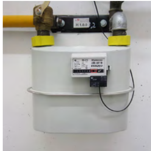
Gaszähler mit Impulsausgang Foto: ABI, Abteilung Energiemanagement
