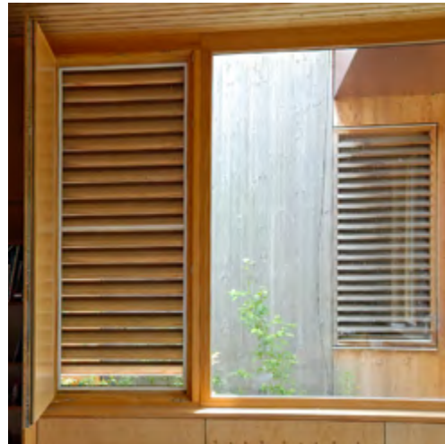
Nachtlüftungsöffnung Albert-Schweitzer-Schule, Foto: ABI, Abteilung Energiemanagement
